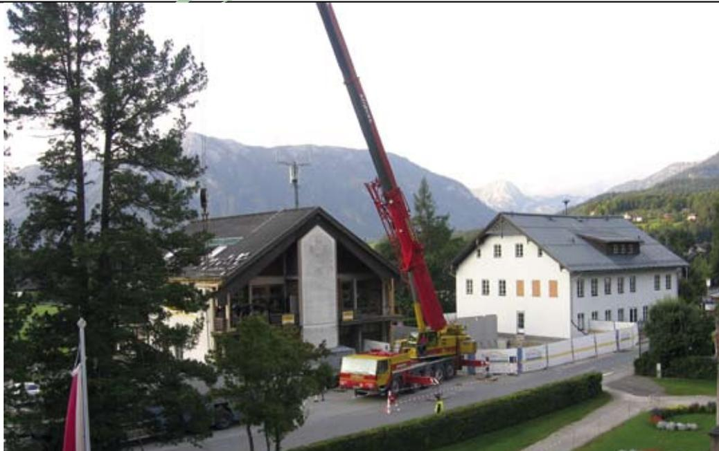
ment hat zwischen 5 und 6 Tonnen, diese wurden passgenau mit dem Kran versetzt – nicht nur für kleine Kinder toll zum Beobachten. Die Decke folgte dann am 16. September – ebenfalls Fertigteil-elemente, welche wieder mittels Schwerlastkranwagen versetzt werden.
